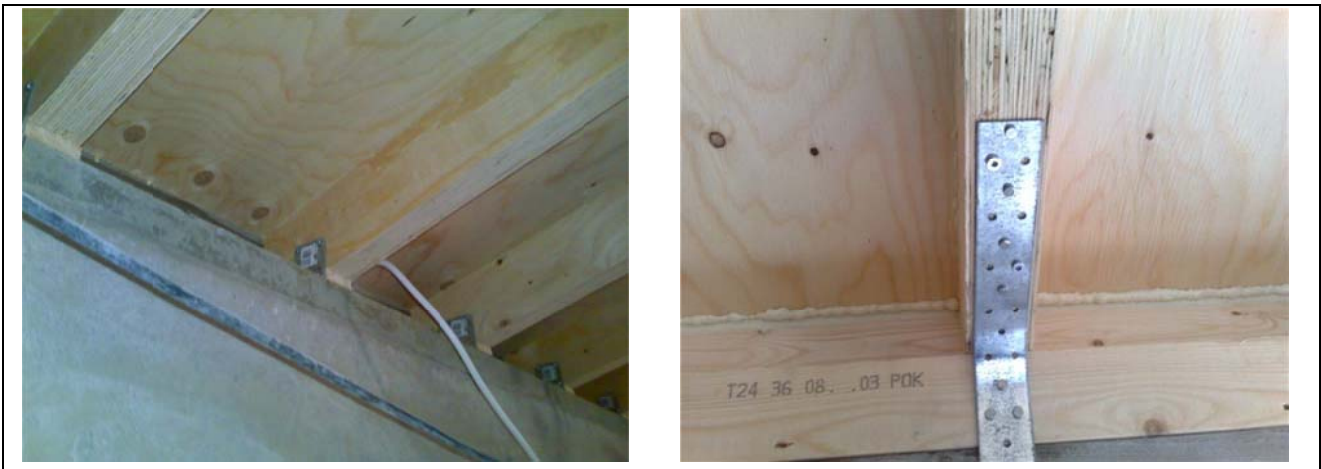
Kuva 6.1 Elementtien kiinnityksiä kahdessa eri kohteessa.
