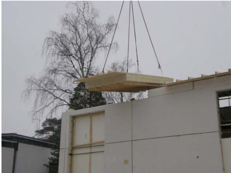
Kuva 8.1. Elementin nostaminen
