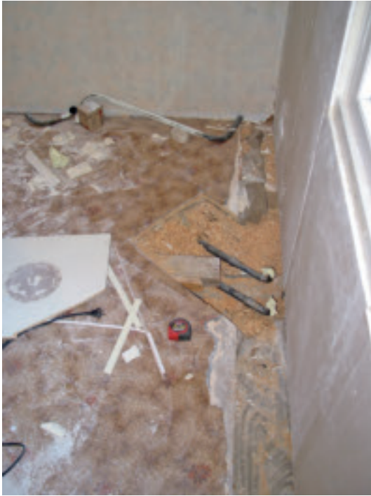
Lattian avauksen yhteydessä voidaan tarkistaa myös LVI-putkitusten kunto.
